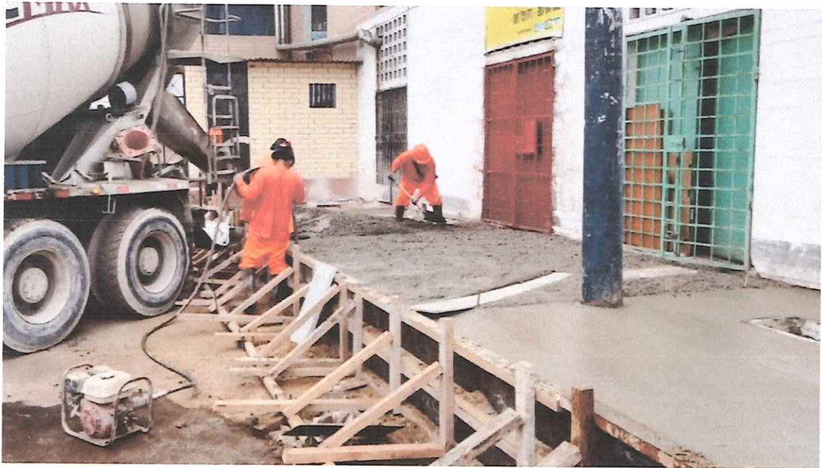
Vaciado de concreto en veredas y así mismo vibrado del elemento en Ca. Juan de Arona.
