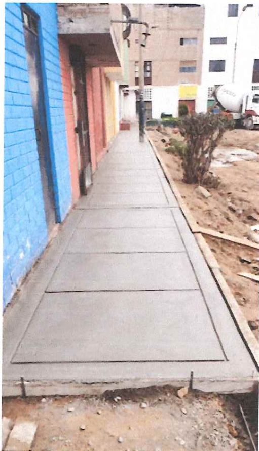
Vaciado de concreto en veredas y así mismo vibrado del elemento en Ca. Juan de Arona.
