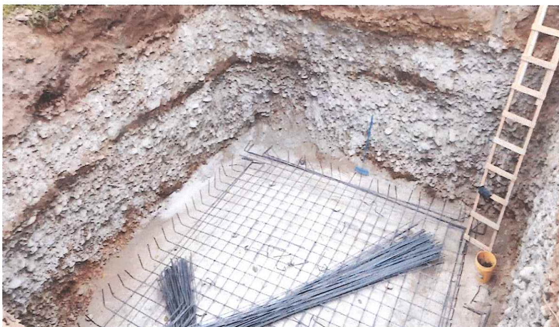
Trazo y habilitación de la malla de acero corrugado G60 en cisterna para el sistema de riego.
