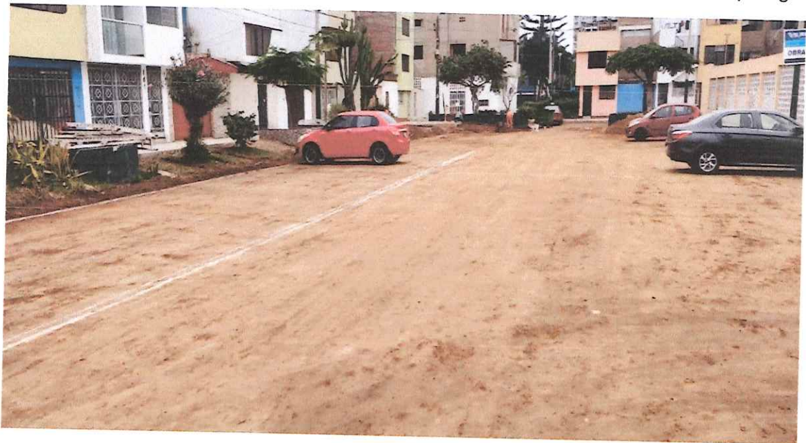
Se aprecia Trazo para proceder a la excavacion del sardinel sumergido en Pje. Felipe Pardo y Aliaga
