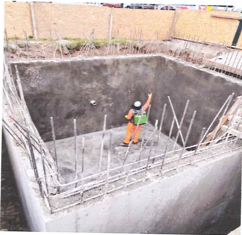
Curado de cisterna con aditivo membrana curador, elemento químico que ayuda a curar con su propio contenido de humedad
