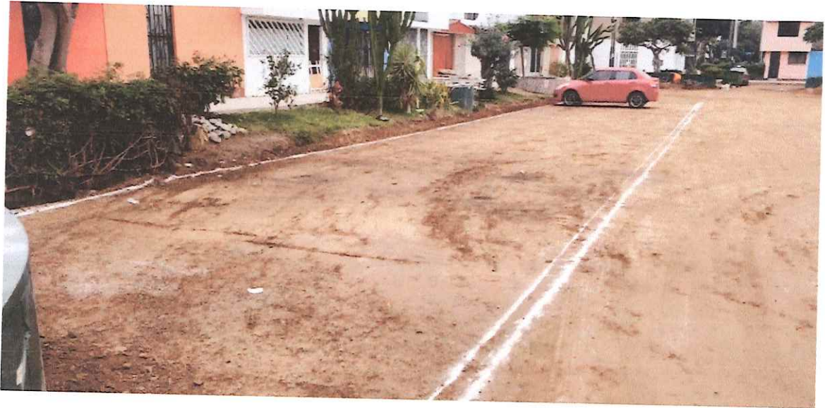
Se aprecia Trazo para proceder a la excavacion del sardinel sumergido en Pje. Felipe Pardo y Aliaga
