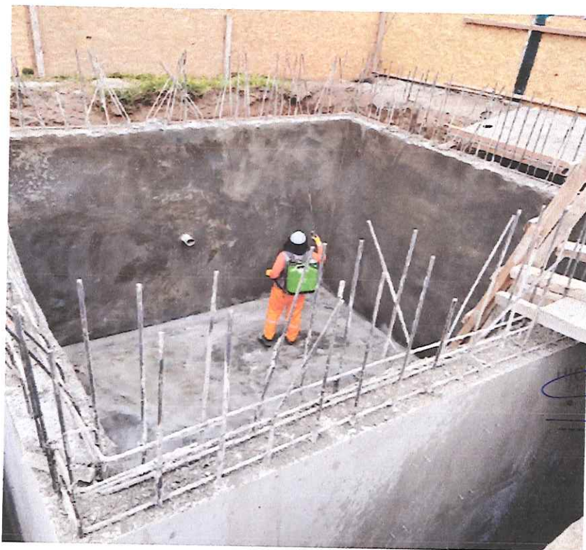
Curado de cisterna con aditivo membrana curador, elemento químico que ayuda a curar con su propio contenido de humedad
