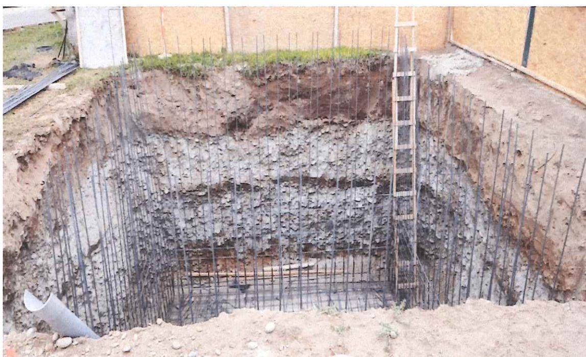
Trazo y habilitación de la malla de acero corrugado G60 en cisterna para el sistema de riego.
