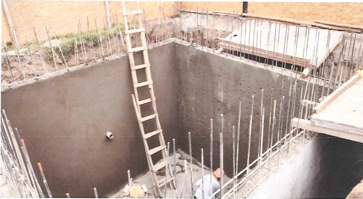
Tarrajeo de paredes interiores y piso en cisterna con impermeabilizante.
