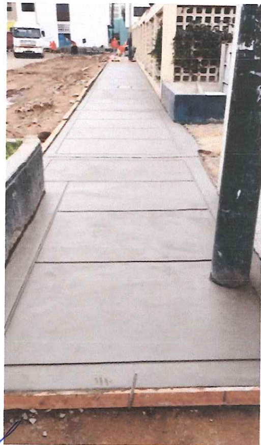
Vaciado de concreto en veredas y así mismo vibrado del elemento en Ca. Juan de Arona.
